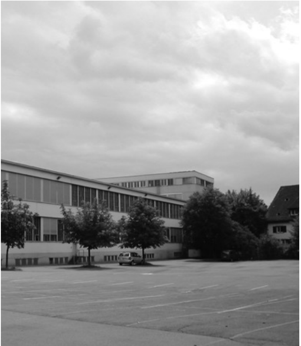
Im Jahr 1833 erwarb die Firma Rieter die ehemaligen Gebäude des Klosters Töss, welche in den folgenden Jahren umgebaut oder abgerissen wurden. Die Klosterkirche wurde bis ins Jahr 1916 als Fabrikhalle genutzt, anschliessend aber abgebrochen. Am rechten Bildrand ist das letzte, noch erhaltene Gebäude des ehemaligen Klosters zu erkennen.
