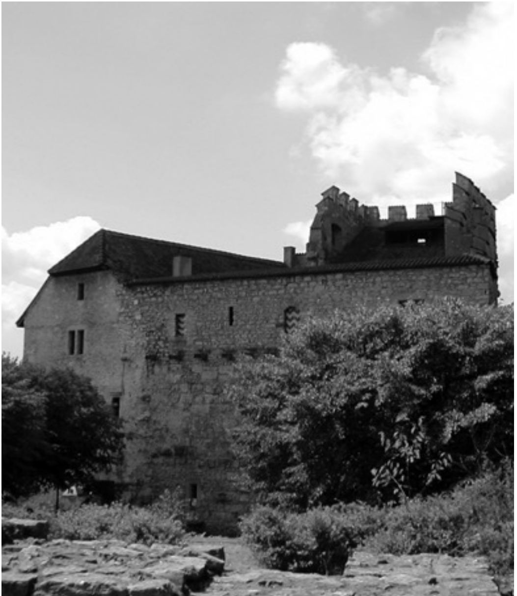
Die Habsburg liegt auf dem lang gestreckten Hügelkamm des Wülpelbergs in der Gemeinde Habsburg im Kanton Aargau. Gründer der Habsburg soll um 1020 Graf Radbot von Altenburg gewesen sein, der im östlichen Teil der heutigen Burganlage einen Turm errichten liess.
